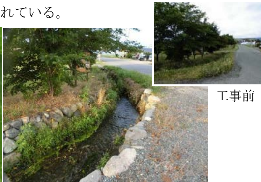
護岸工事後の④地点付近の様子
