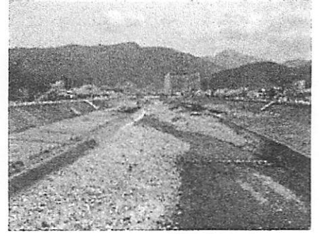
筑摩橋から上流を望む
