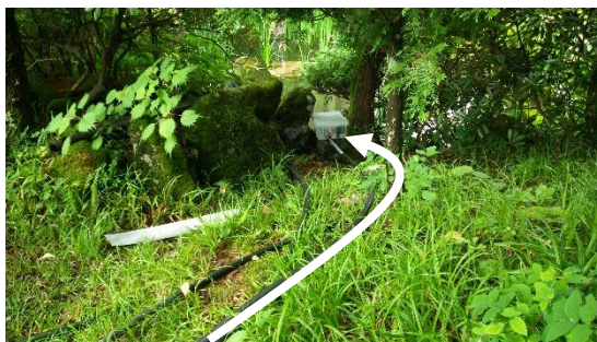
池まで水道管で水を引く 高低差4m 水道管は内径21mm 太目で丈夫なもの
