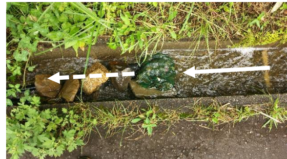
取水口 いろいろな物が流れてくるので ネットに小石を詰めたもので侵入を防ぐ
